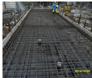
รูปที่17. งานบันได ST 1 ขึ้นชั้นคาดฟ้า
