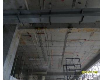
รูปที่ 10 .งานเดินท่อ และวางสายไฟ ชั้น 2
