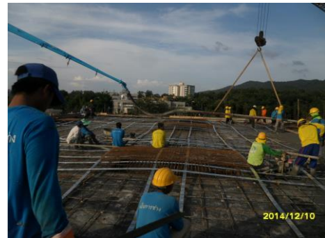
รูปที่5. งานเทคอนกรีตพื้นชั้นดาดฟ้า
