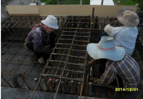
รูปที่1. งานผูกเหล็กเสริมกันแผ่นดินไหว
