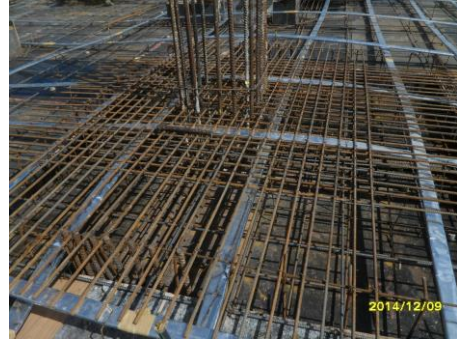
รูปที่4.งานเหล็กเสริมพื้น ครอบหัวเสา
