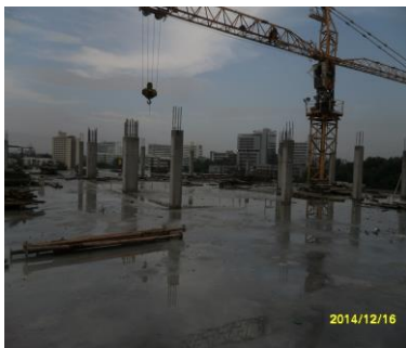
รูปที่14. งานประกอบแบบ และ เทคอนกรีตเสา
