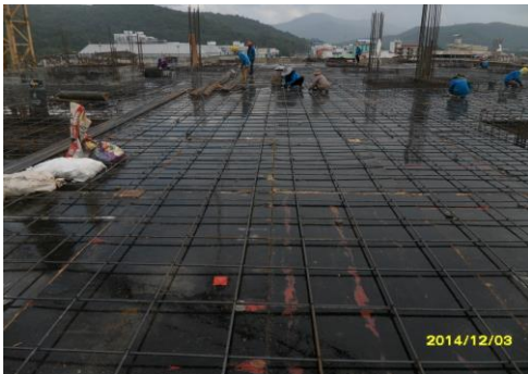
รูปที่2. งานผูกเหล็กพื้นชั้นดาดฟ้า
