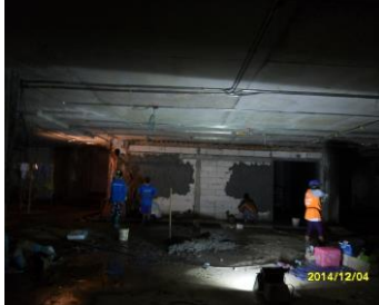
รูปที่19. งานฉาบผนังห้องชั้นใต้ดิน
