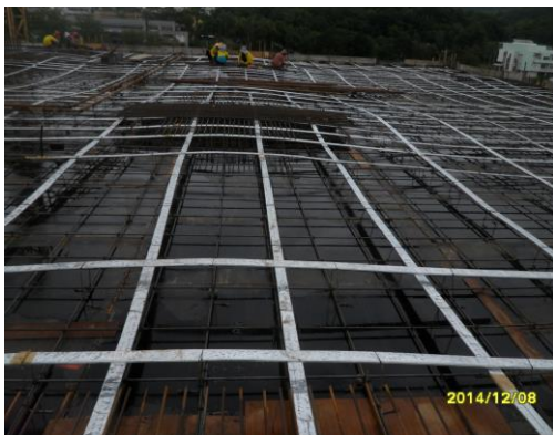
รูปที่2. งานผูกเหล็กพื้นชั้นดาดฟ้า
