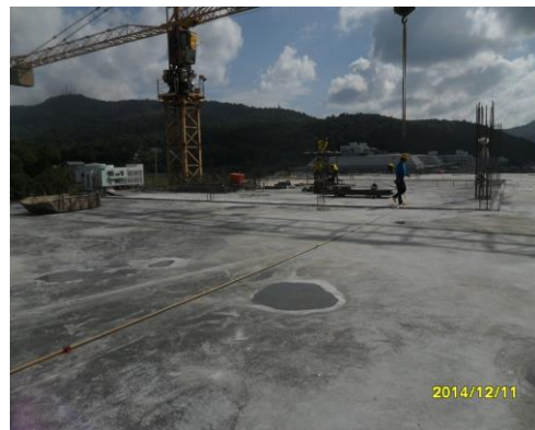
รูปที่6. งานพื้นชั้นดาดฟ้าแล้วเสร็จ
