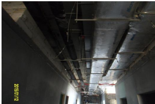
รูปที่2. งานหุ้มฉนวนท่อค้ำแอร์ ชั้น 1
