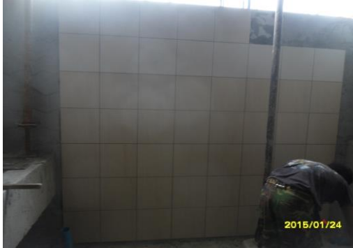
รูปที่13. งานปูกระเบื้องผนังห้องน้ำ ชั้น 1
