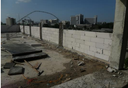
รูปที่1. งานก่ออิฐกันตกผนังชั้นดาดฟ้า
