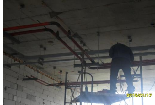
รูปที่5. งานเชื่อมต่อท่อน้ำเย็นแอร์ ชั้น 3
