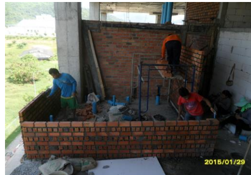
รูปที่6. งานก่ออิฐผนังห้องน้ำ ชั้น 4
