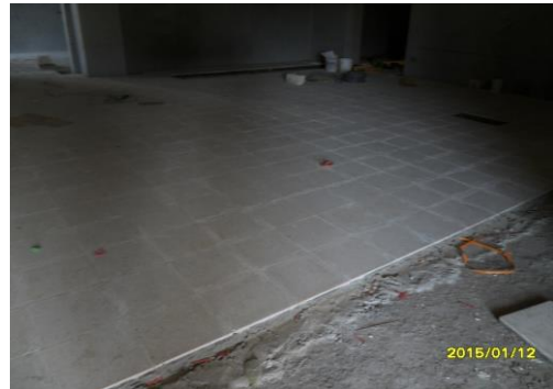
รูปที่ 11 . งานปูหินขัดห้องฉุกเฉิน สัตว์วิกฤต ชั้น 1
