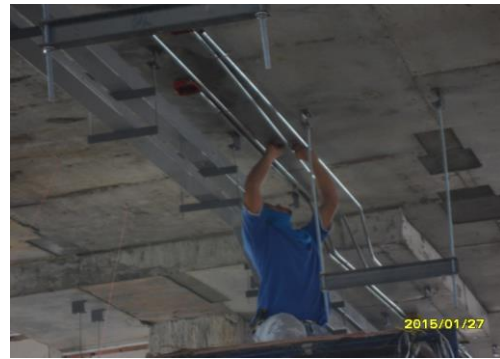
รูปที่ 10 .งานเดินท่อ และวางสายเวย์ ชั้น 3
