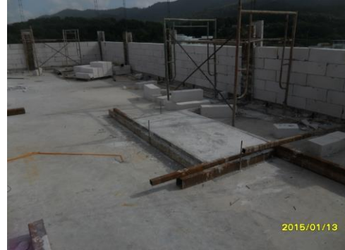
รูปที่4. งานหล่อแทนเครื่องแอร์ ชั้นดาดฟ้า
