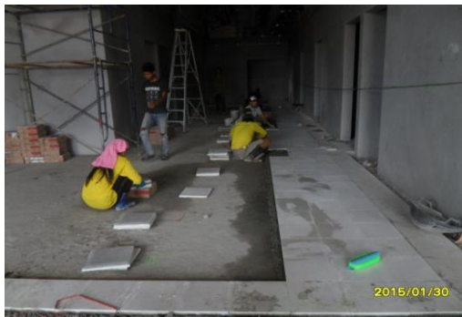
รูปที่3. งานปูกระเบื้องหน้าห้องตรวจ ชั้น 1
