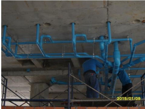
รูปที่ 7. งานเดินท่อน้ำทั้งชั้น 3
