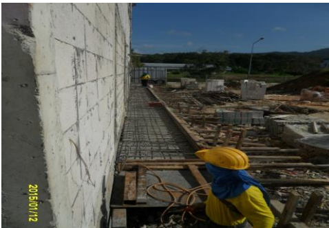
รูปที่ 9. งานผูกเหล็กพื้นข้างอาคาร ชั้น 1
