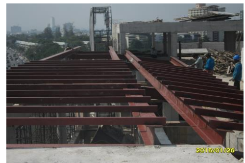
รูปที่ 12 .งานทำหลังคาเหล็กชั้นดาดฟ้า
