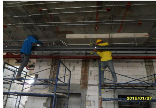
รูปที่17. งานติดตั้งท่อระบายน้ำทิ้งจากห้องปฏิบัติการ ชั้น 3
